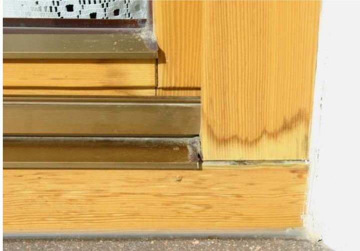
**Abbildung 12:** Beginnende Feuchtigkeitsschäden etwa ein Jahr nach dem Einbau durch Eindringen von Feuchtigkeit über eine ungeschützte Konstruktionsfuge. Wegen der geringen Schichtdicke des Anstrichs sind keine Anstrichschäden, sondern nur Wasserbeeinträchtigungen am Holz erkennbar.
