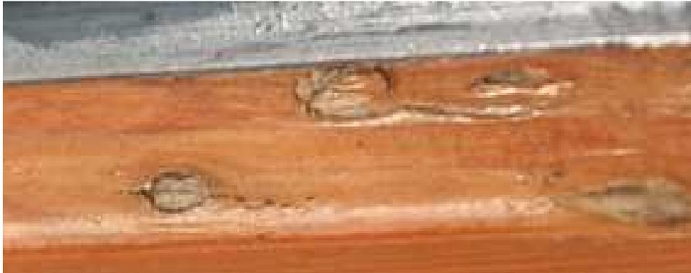
Abbildung 7: Anstrichschäden durch Hagelschlag
