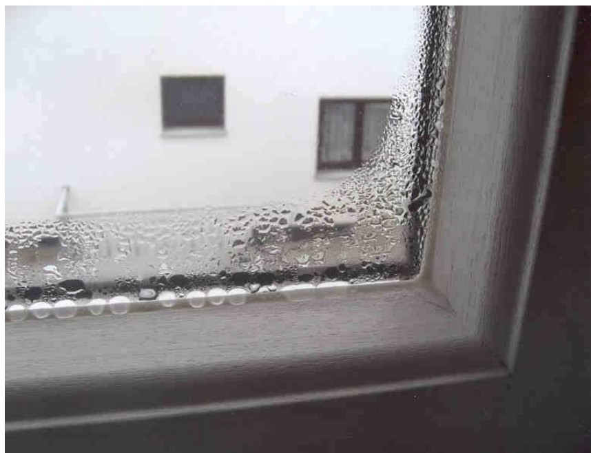
Abbildung 20: Tauwasserbildung im Randbereich des Isolierglases
