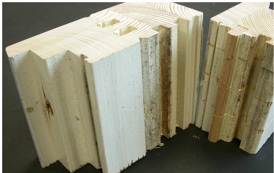
Abbildung 16: Schimmelpilzbildung aufgrund des Eintritts von warmer Raumluft in eine von der Raumseite offene Konstruktionsfuge
