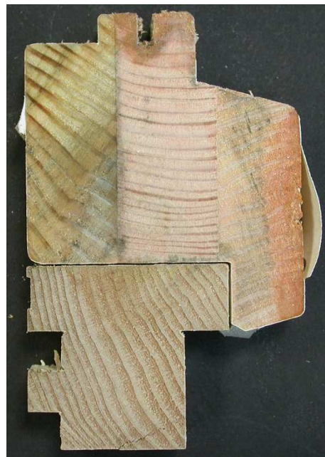
Abbildung 23: Feuchtigkeitsverteilung an einem Blendrahmenquerschnitt als Folge der Vorschädigung des Holzes
