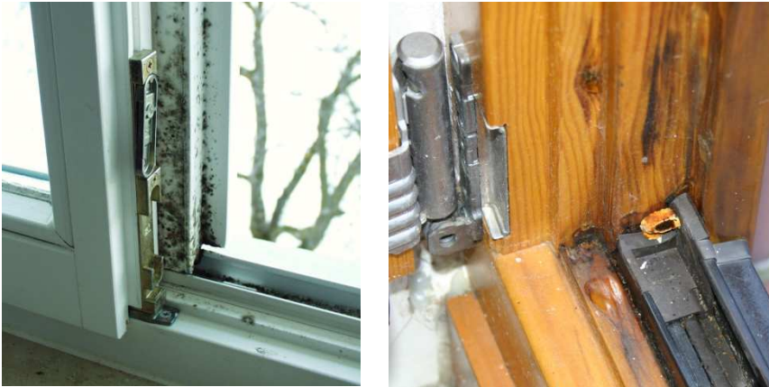
Abbildung 17: Schimmelpilzbildung und Holzzerstörung durch Pilzbefall als Folge von Tauwasser in den Falzen
