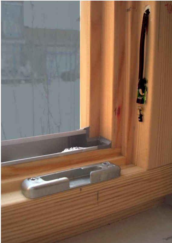
Abbildung 34: Messaufnehmer für Temperatur und Luftfeuchtigkeit im Falzraum des Versuchsfensters
