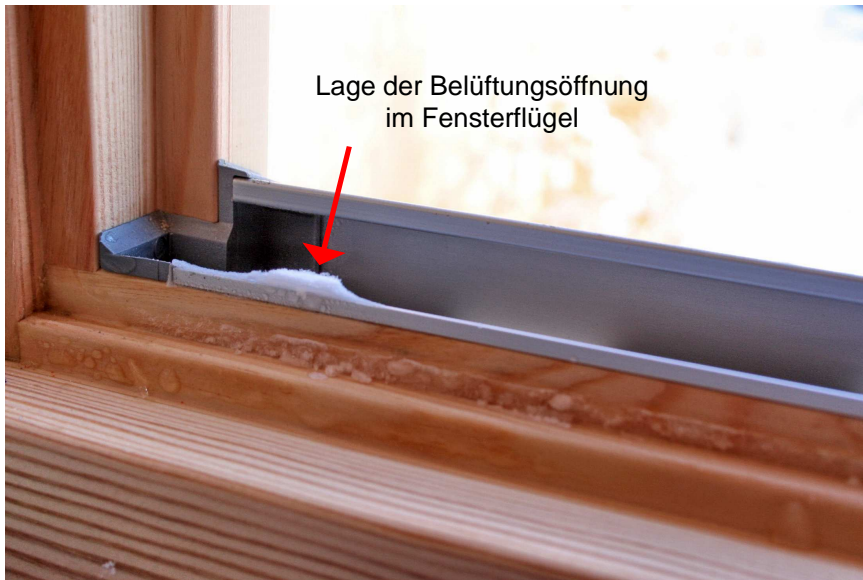
Abbildung 55: Eisablagerungen in der Dichtungsebene eines Fensters. Der Pfeil markiert die Lage der Belüftungsöffnung für die Glasfalzbelüftung.
