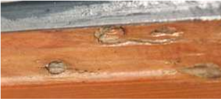
Abbildung 15: Anstrichschäden durch Hagelschlag
