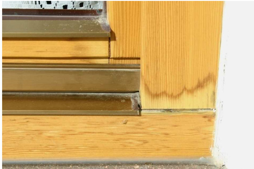
Abbildung 14: Beginnende Feuchtigkeitsschäden etwa 1 Jahr nach dem Einbau durch Eindringen von Feuchtigkeit über eine ungeschützte Konstruktionsfuge. Wegen der geringen Schichtdicke des Anstrichs sind keine Anstrichschäden, sondern nur Wasserbeeinträchtigungen am Holz erkennbar.
