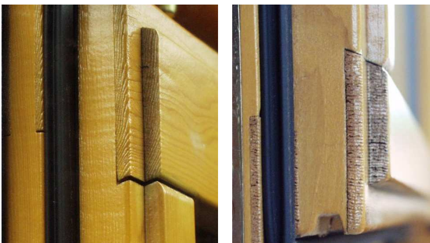
Abbildung 13: Offene Fugen an Rahmenverbindungen aufgrund unzureichender Verleimung als häufige Schadensursache bei Fenstern
