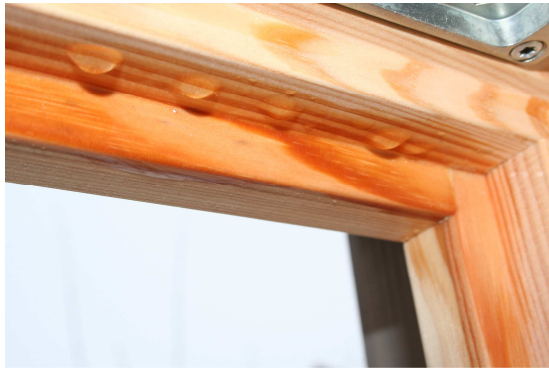
Abbildung 7: Tauwasserbildung im Falz zwischen Flügel und Blendrahmen
