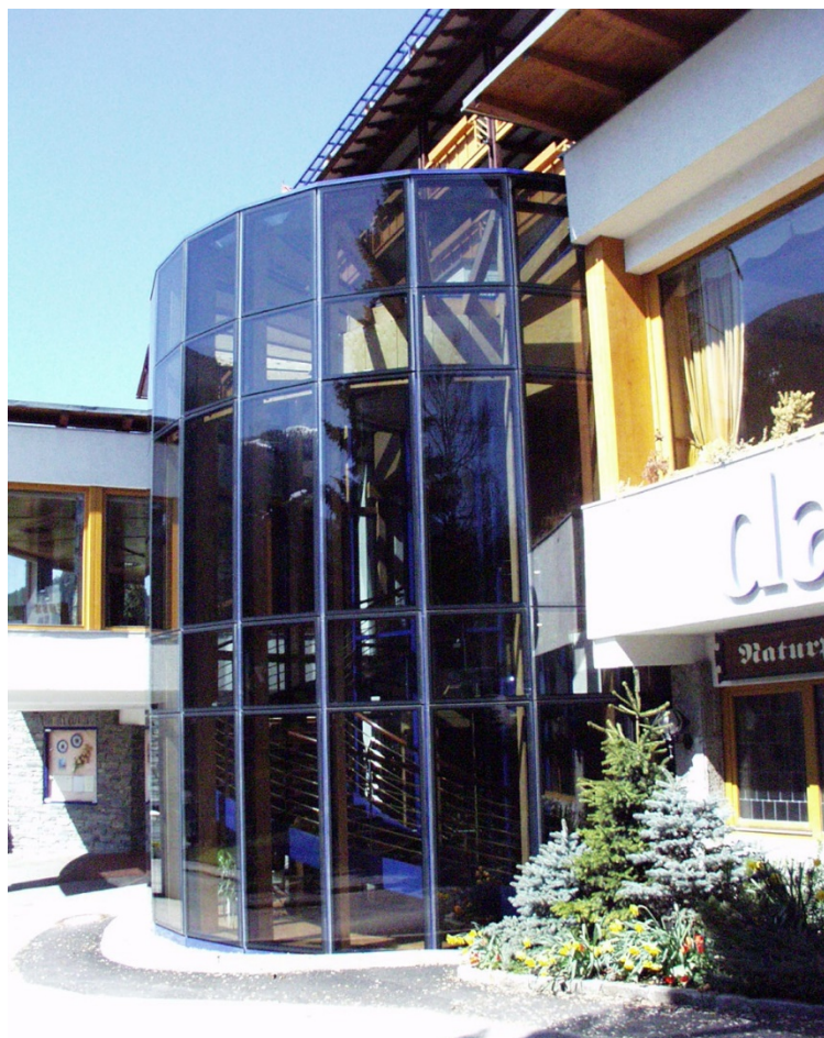
Abbildung 1: Ansicht einer Pfosten-Riegel-Fassade
