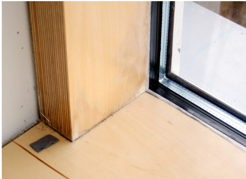
Abbildung 14: Tauwasserbedingte Schäden an einer Pfosten-Riegel-Fassade
